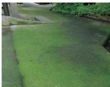
コンクリートの通路
